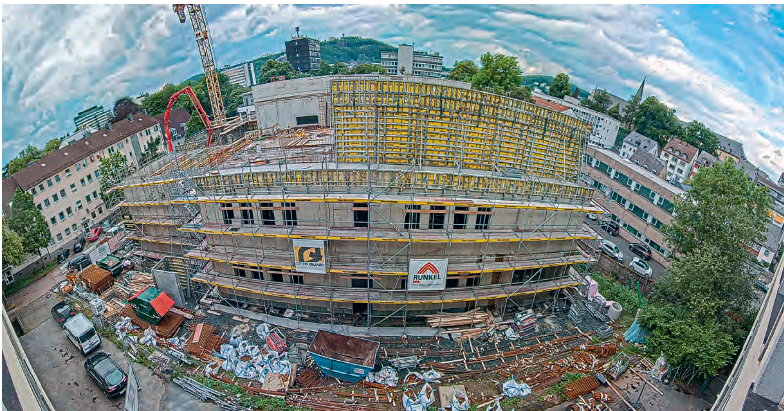
Die Baustelle des neuen »Haus der Musik« in der Oranienstraße in Siegen
